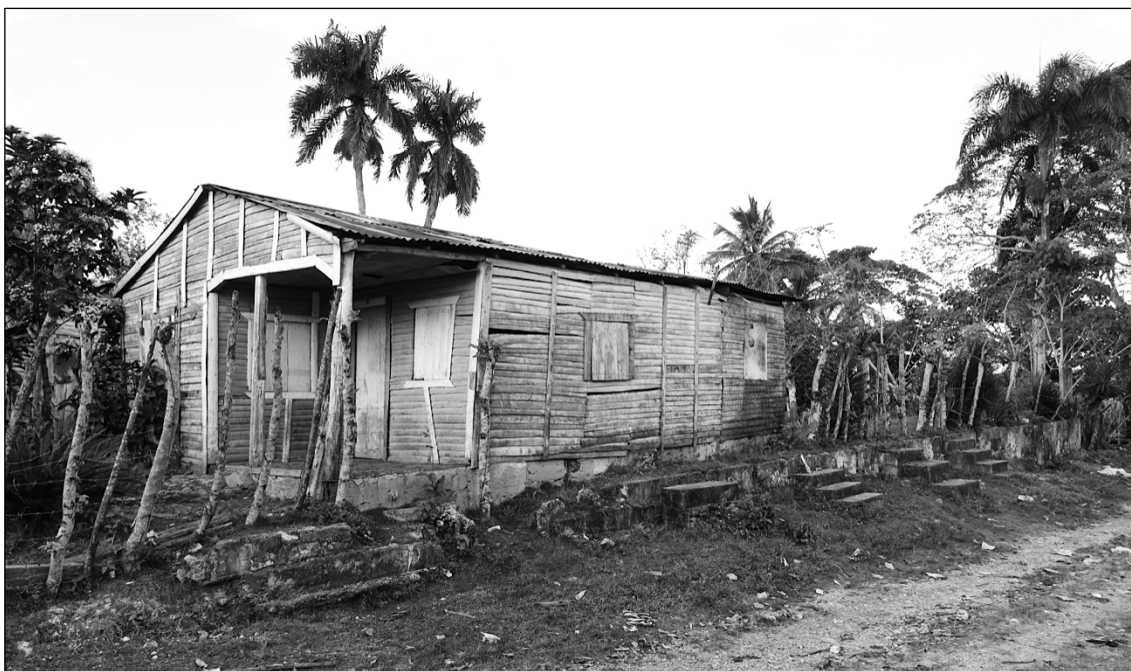
Fig.7: Casa familiare in legno edificata dove prima vi era un barracón (è ancora visibile la base in cemento con gli scalini che portavano all’ingresso di ogni camerata).
