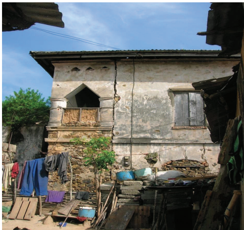
Figura 22. Lato orientale della casa di Mensah Kuma. Dixcove, marzo 2008. (Foto dell'A.).
