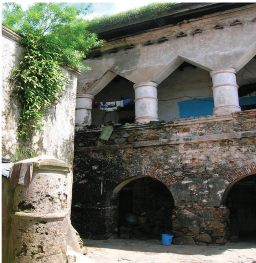
Figura 21. Lato orientale della casa di Mensah Kuma. Dixcove, marzo 2008. (Foto dell'A.).
