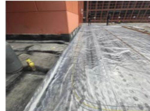
\approx 800\text{ m} di fibra ottica posata sotto la pavimentazione
